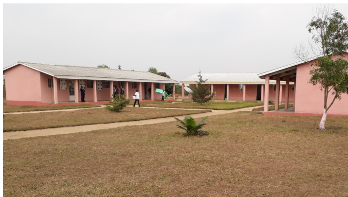
Vue de l'extérieur des salles de classe de l'école normale DNS Mbankana
